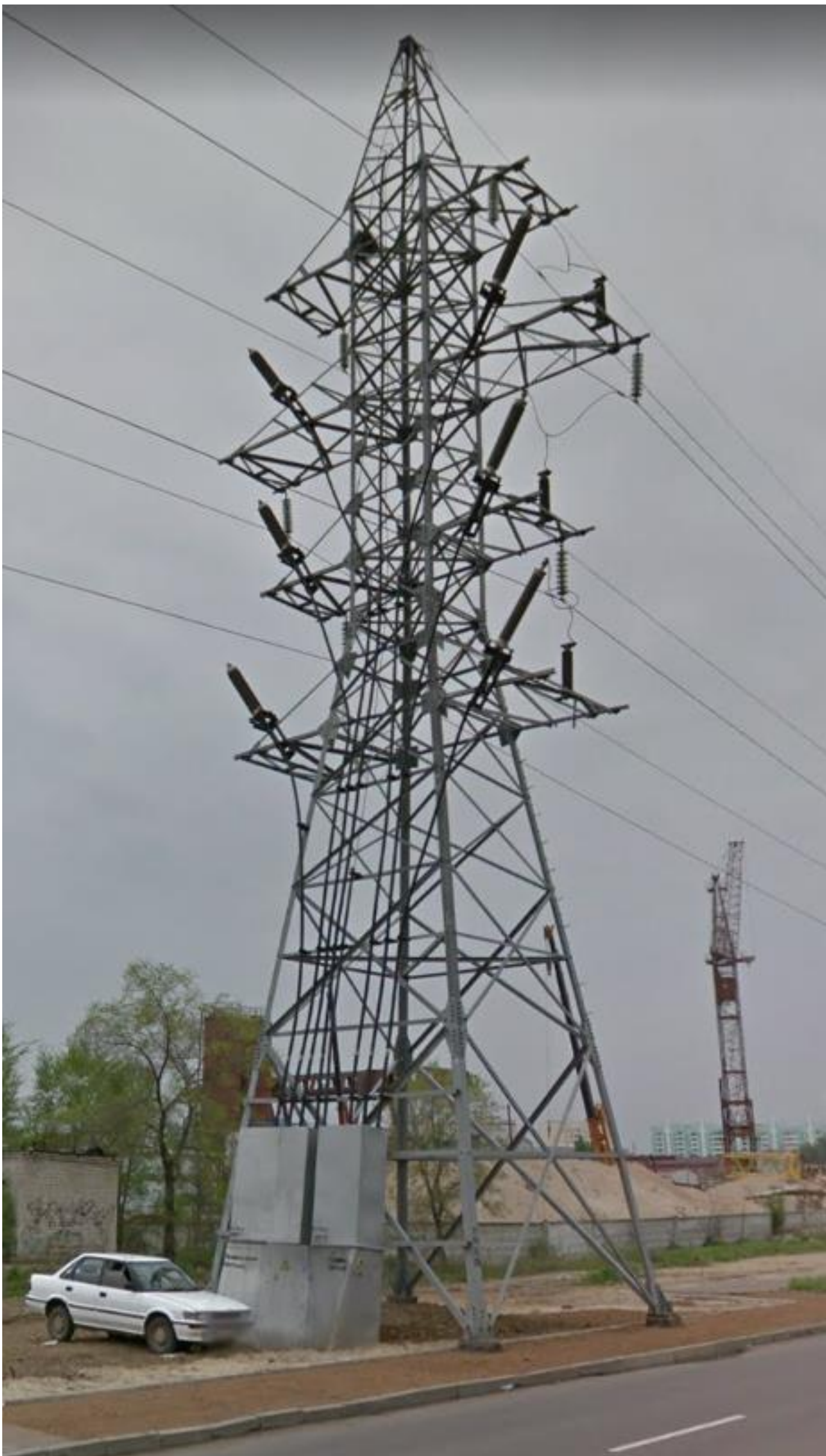
Пример выполнения отпайки на ПС «Светланская»
