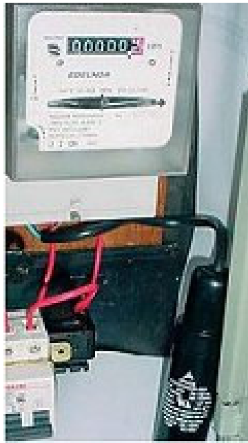
Рисунок 9 - Установка конденсатора HomeCap в ящике учета
