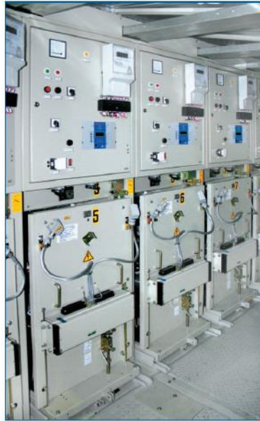
Рисунок 7 – Общий вид КРУ СЭЩ-59
