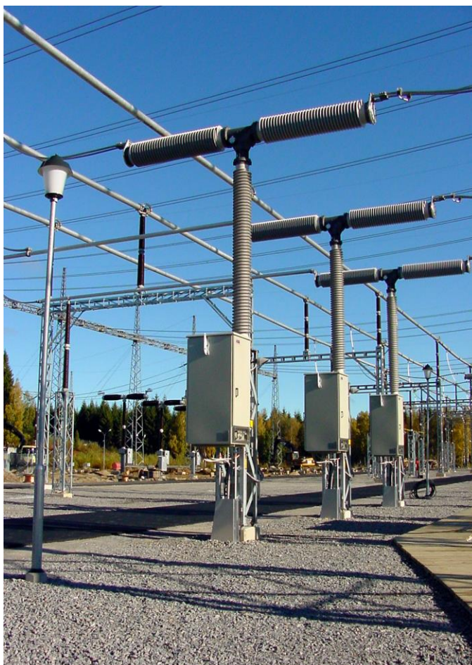
Рисунок 3 – Общий вид выключателя HLP245B1
