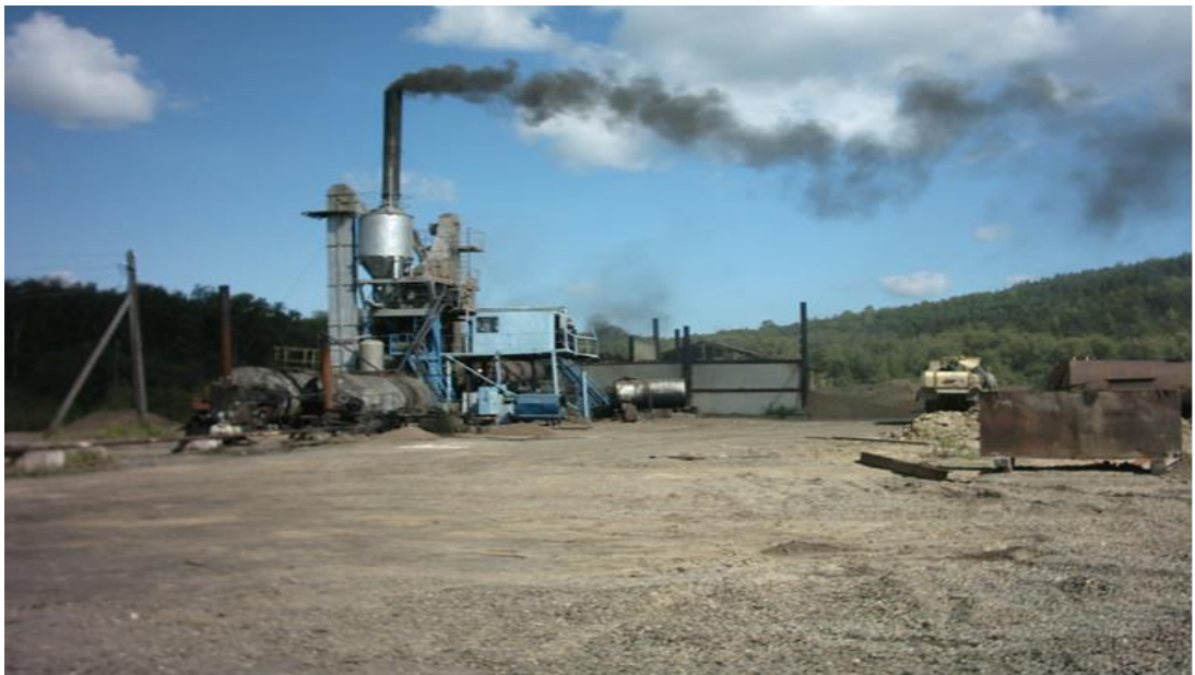
Рисунок 3 – Асфальтобетонный завод ( с Ж/Д тупиком)
