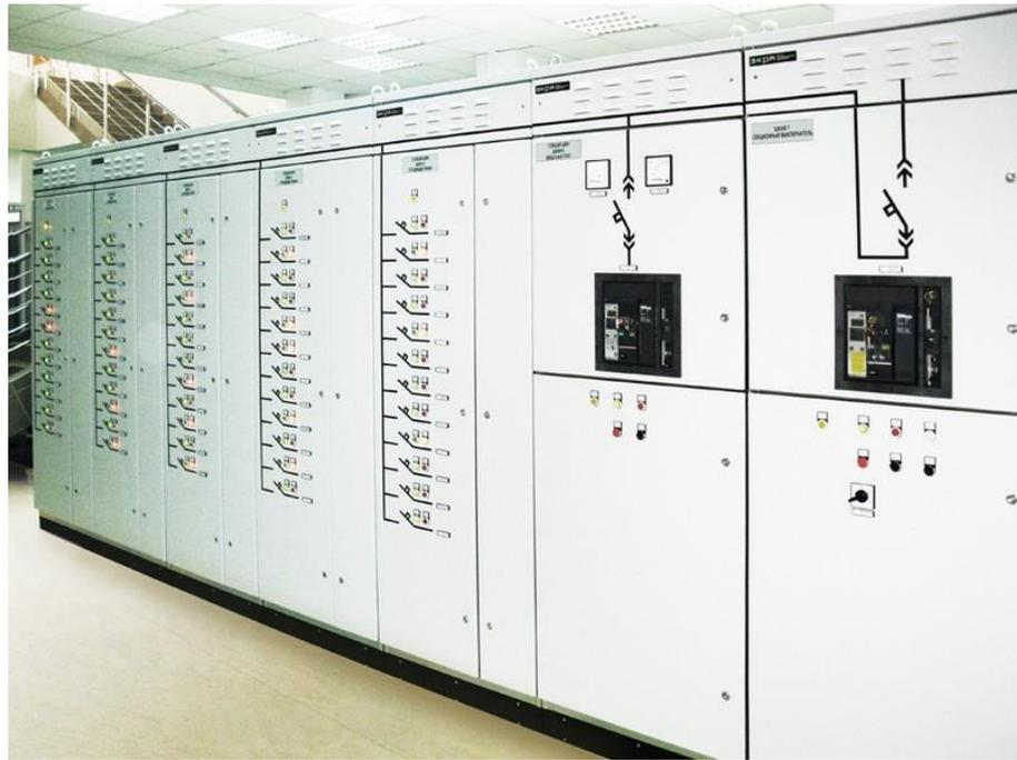
Рисунок 7 - Щиты собственных нужд 0,4 кВ серии ШНЭ8350
