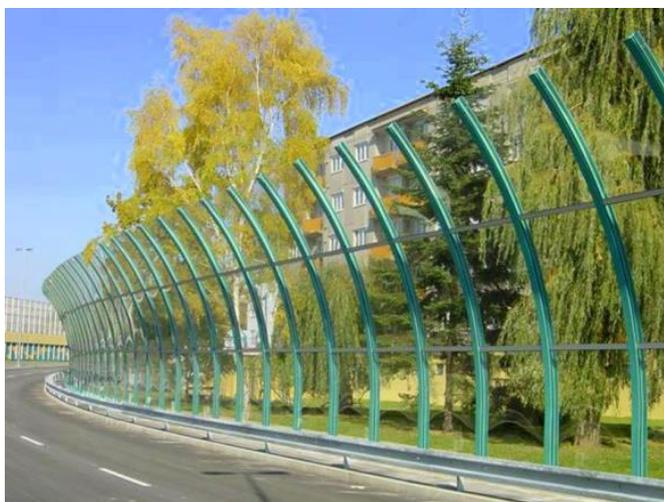
Рисунок 12 – Внешний вид акриловых шумозащитных экранов
