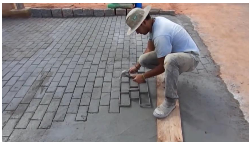
Рисунок В.8 – Создание имитации плитки
