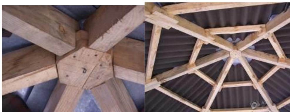
Рисунок В.3 – Соединение стропил
