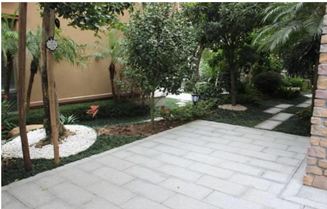
Рисунок А.22 – Фрагмент покрытия плиткой из бетона
