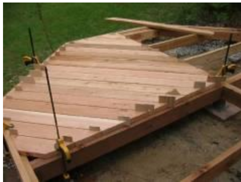
Рисунок В.2 – Укладка пола
