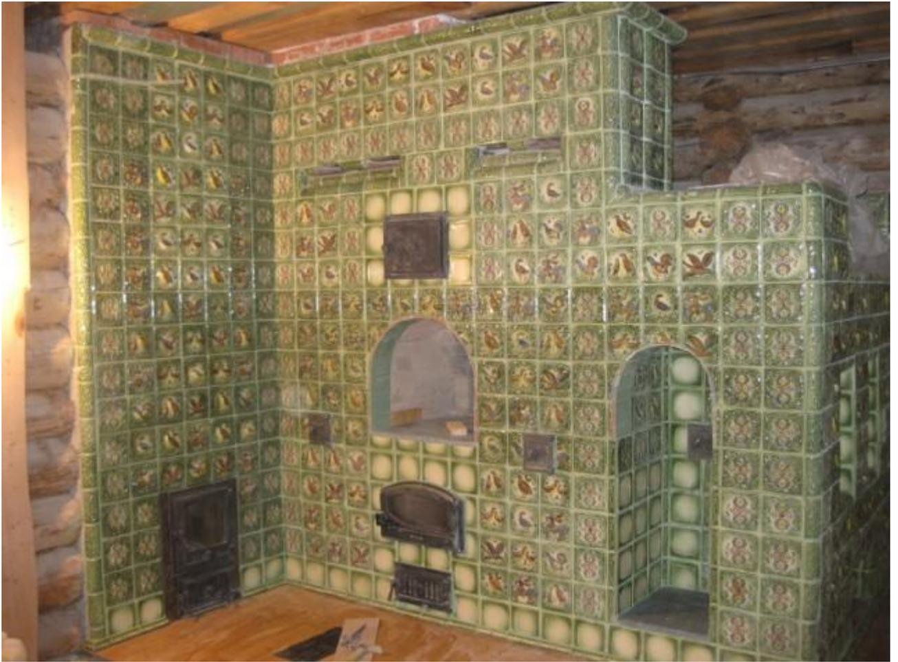
Рисунок А.2 – Пример использования изразцов в печи
