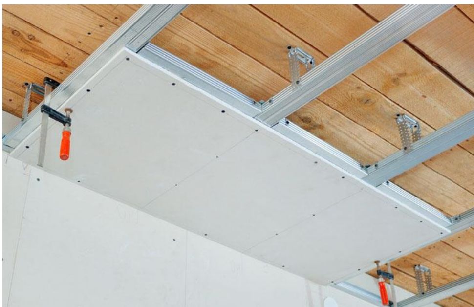
Рисунок Д.4 - Монтаж подвесного потолка
