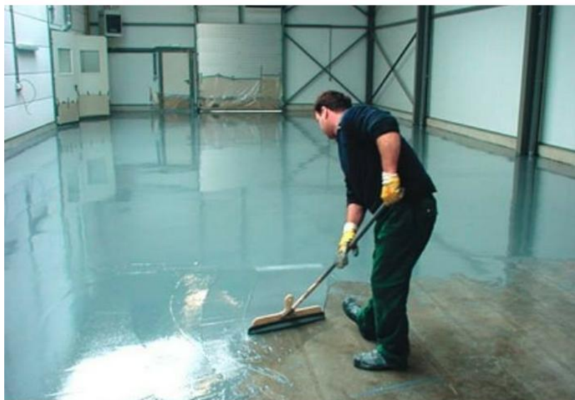
Рисунок Е. 1 - Технология нанесения наливного пола
