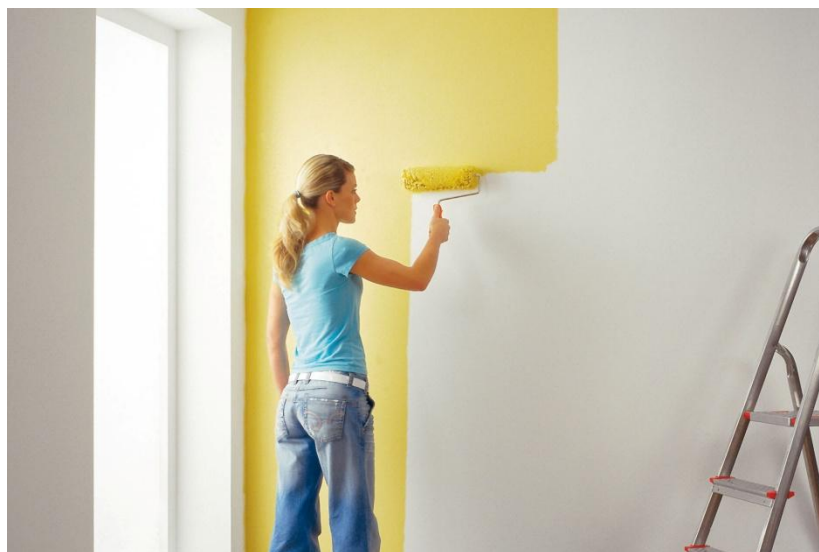
Рисунок Е. 3 - Технология покраски стен
