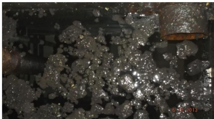
Рисунок 6 – Вспенивание активного ила в аэротенке – осветлителе на ЦОСК «Аэропорт»
