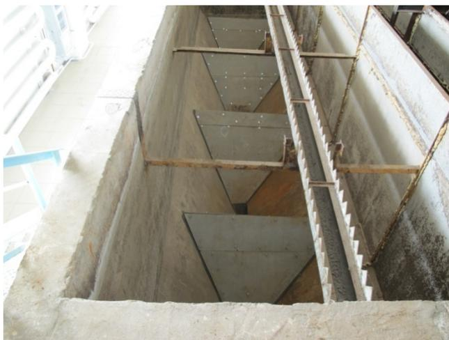
Рисунок 1 – Аэротенк-осветлитель
