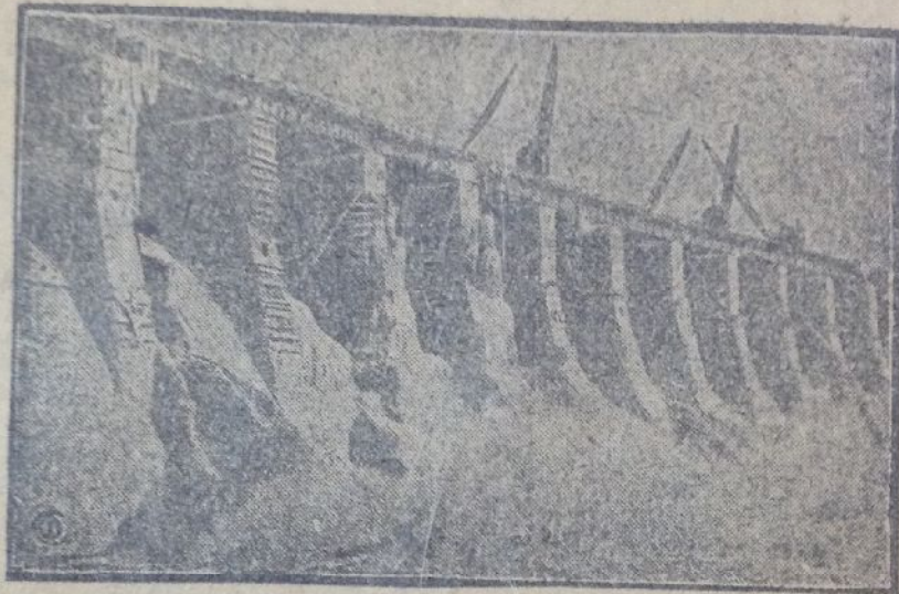
Закончена бетонировка последнего прохода между бычнами Днепровской плотины. НА СНИМКЕ: Панорама плотины Днепростройка (Март 32г.).
