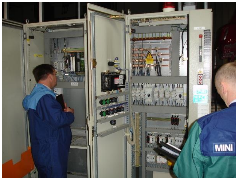
Рисунок 1. Наладка шкафов КРУ 10 КВ
