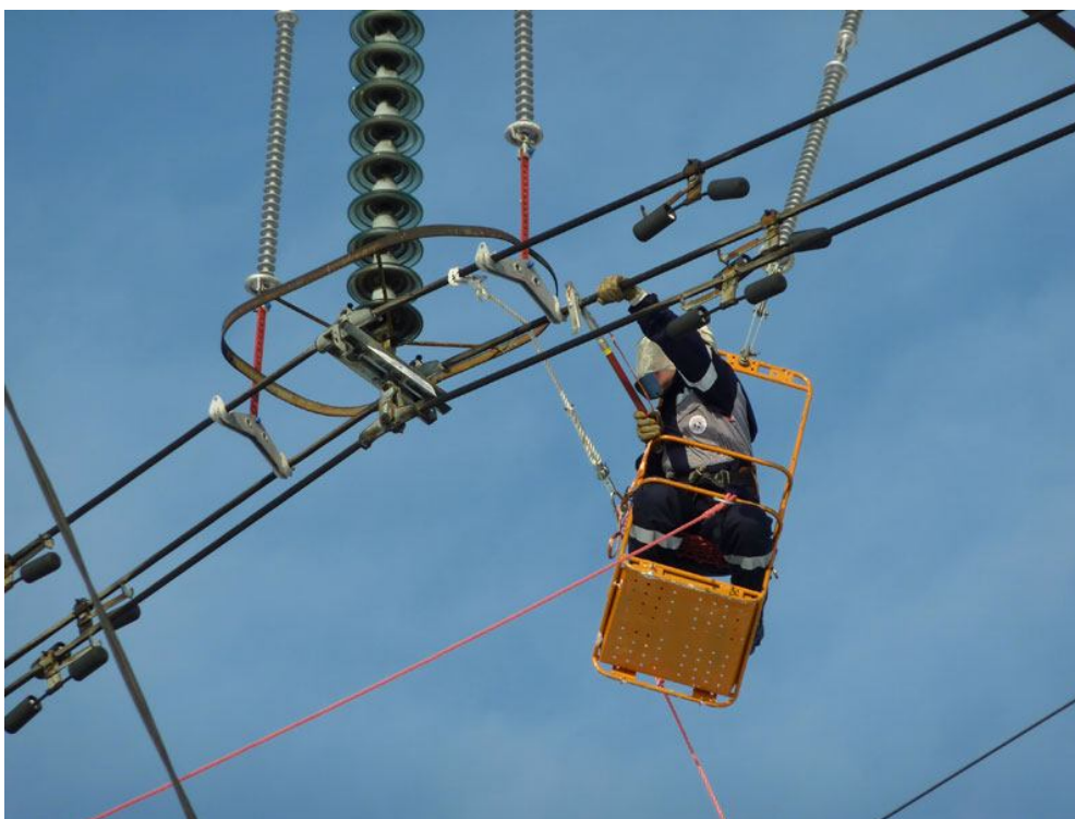
Рис. 50. Работа на воздушной линии без снятия напряжения
