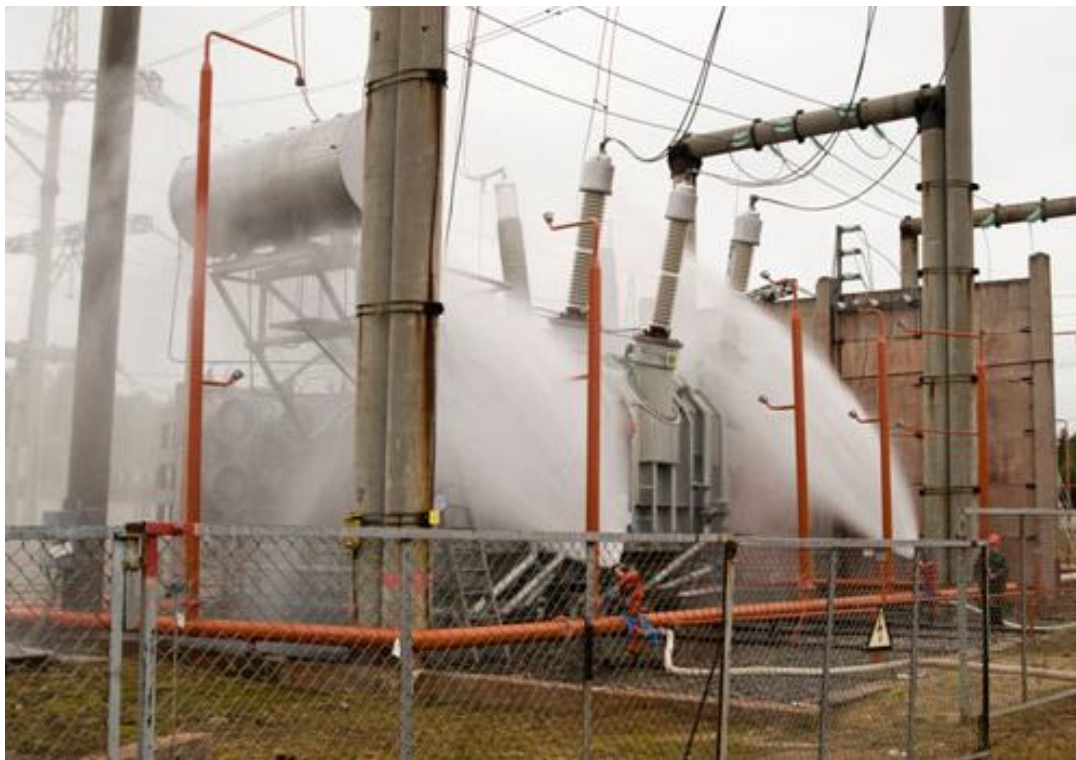
Рис. 22. Стационарная система пожаротушения силового трансформатора [39].
