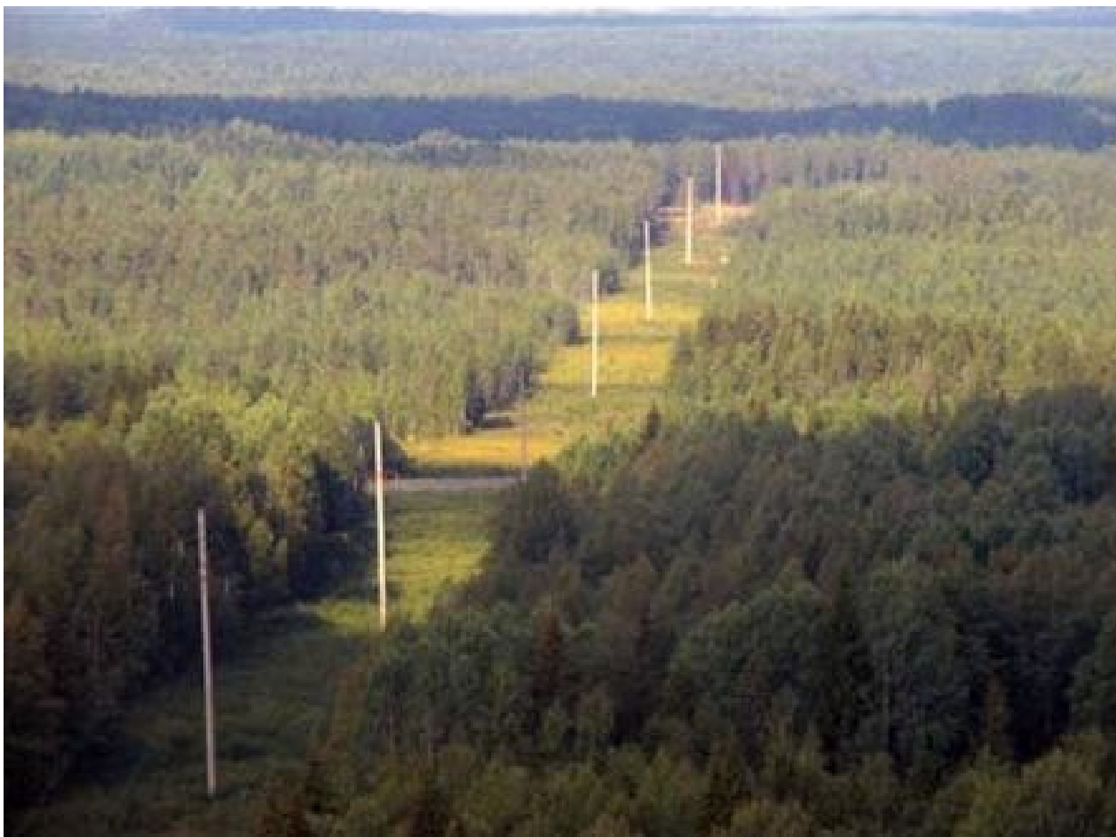
Рис. 44. Просека для прокладки ВЛ в лесном массиве [61].
