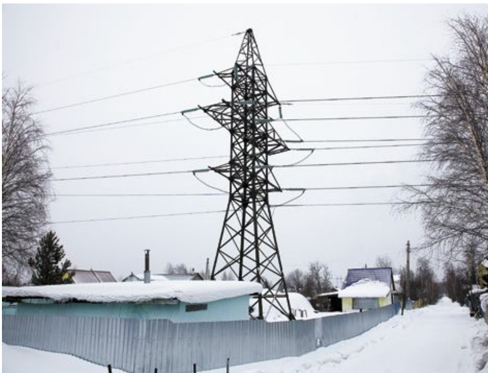
Рис. 45. Нарушение требований [59] – землепользователь включил часть охранной зоны линии в свое подворье [62].
