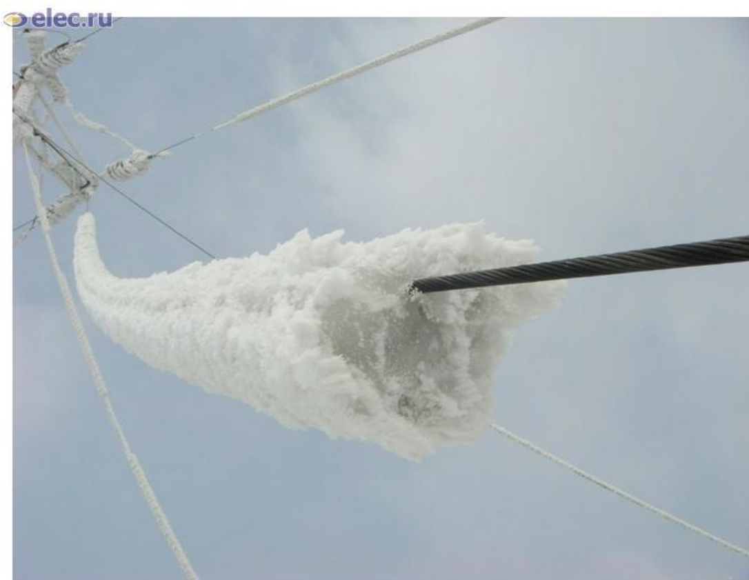
Рис. 47. Гололед на проводах и опорах ЛЭП [64].
