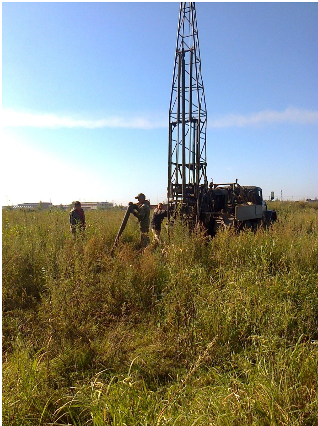
Рис. 5. Самоходная буровая установка ударно-канатного бурения (фото автора)
